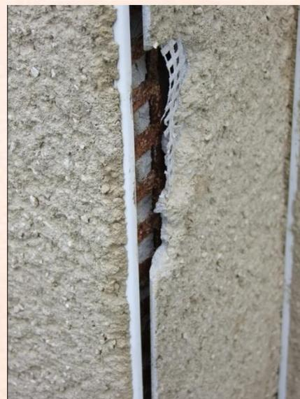
Der Schaden in Form von Rissen und Abplatzungen in 50 m Höhe waren vom Boden aus nicht zu erkennen.
