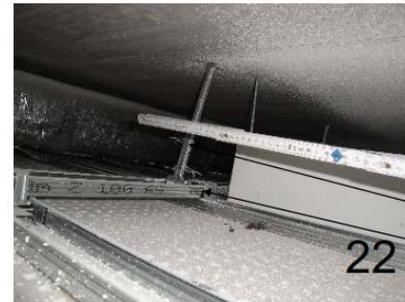
Grundprofilabstand bis zu 1600 mm
